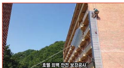
호텔 외벽 안전 보강공사
