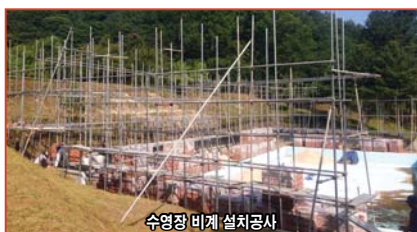
수영장 비계 설치공사
