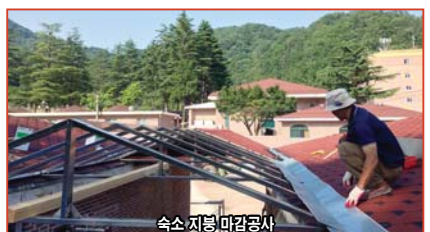
숙소 지붕 마감공사
